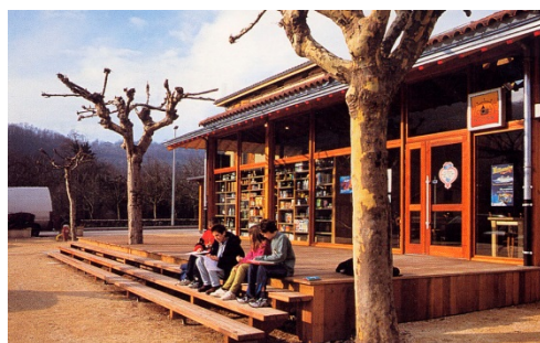
Poliénas Isère : cas d'un bâtiment multi services
