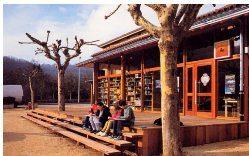
Poliénas Isère : cas d'un bâtiment multi services
