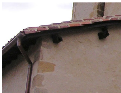
Rive traditionnelle à deux tuiles scellées
