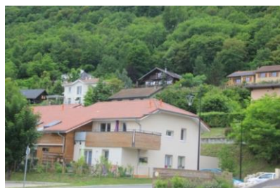
Bâtiment mixte : logements activités libérales Saint-Vincent-de-Mercuze, Grésivaudan
