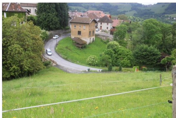
Accès vu depuis le chemin des Contamines
