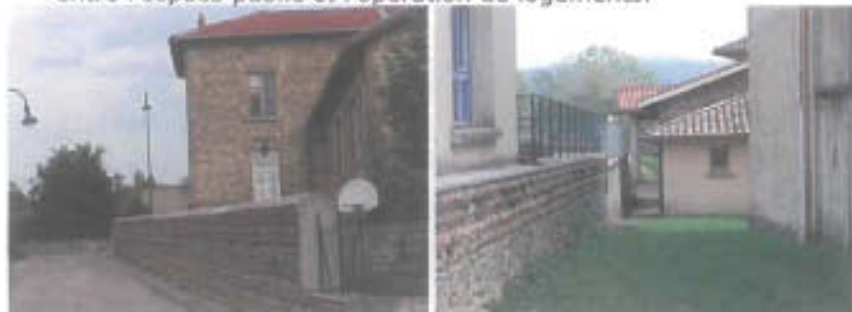
Mur en galets roulés de l'école, à conserver
