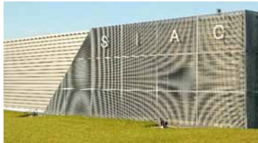
Atelier de câblage à Andrezé (49)
