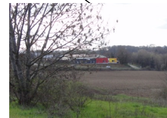
Des façades colorées et un traitement routier
