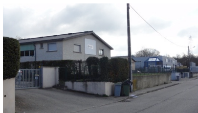
Des clôtures composées principalement de murets et de grillages
