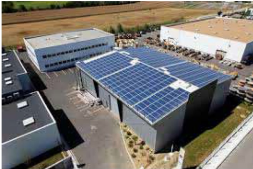
Panneaux photovoltaïques sur toiture inclinée - A PRIVILÉGIER
