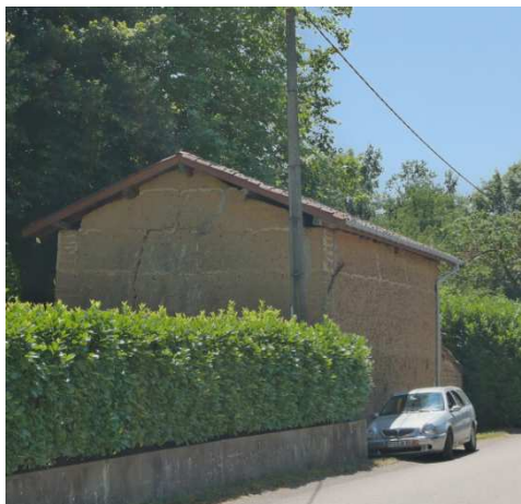
Désordres sur la façade d'une grange au Molard
