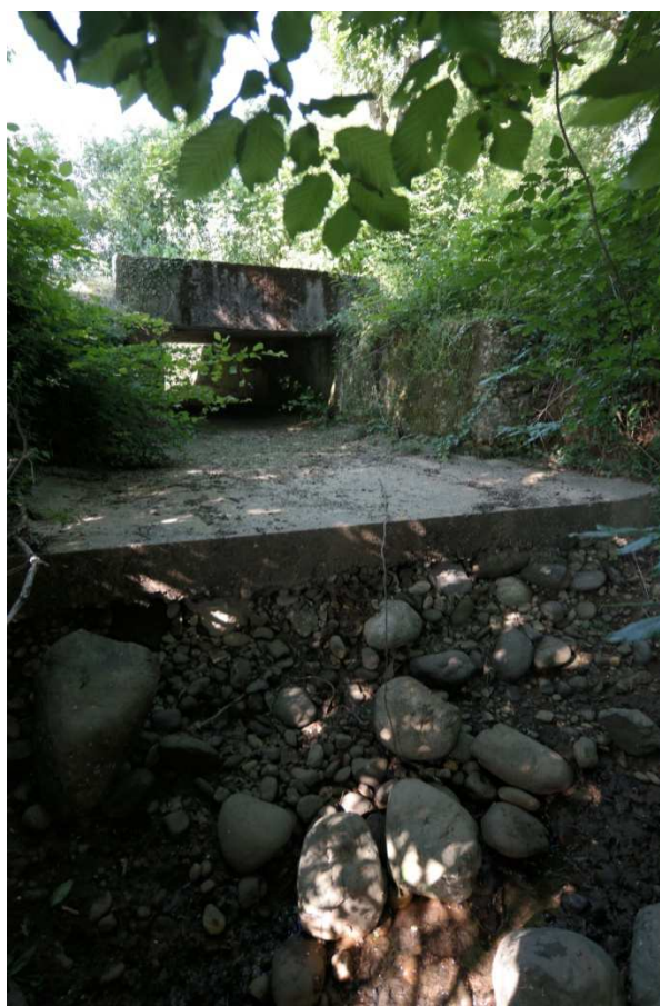
Pont-cadre du chemin du Bois de Revel sur le ruisseau du Chalon
