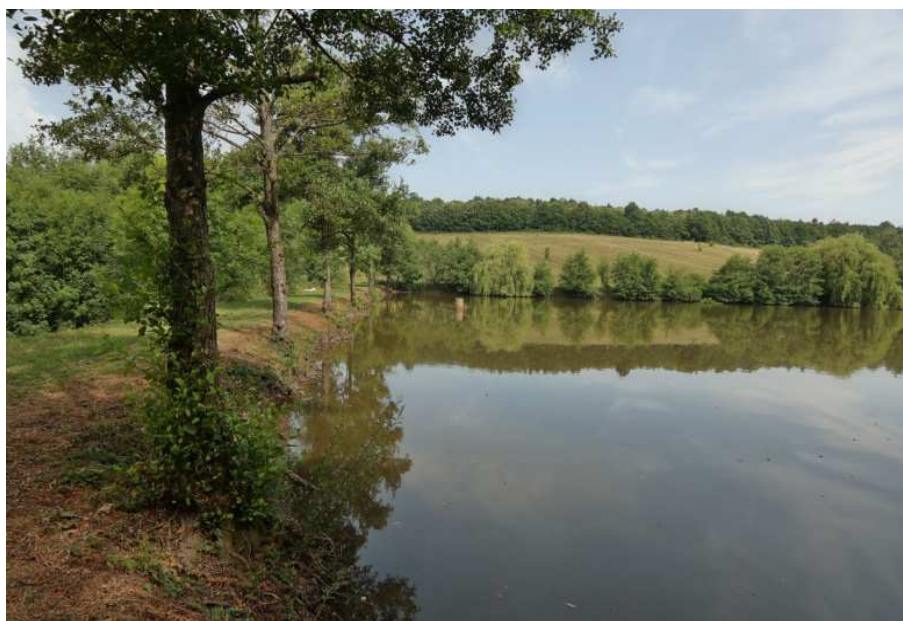
Digue de l'étang supérieur de la Verrerie
