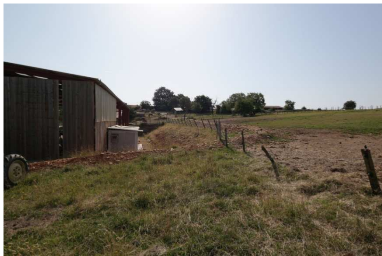
Levée de terre protégeant le manège du centre équestre du ruissèlement de versant
