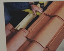
Fixation des tuiles en rive latérale droite par crochet "V2" Réf. CRV02.
