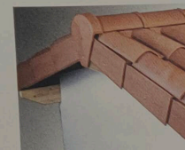
Fixation des rives individuelles et collectives par vis et rondelle d'étanchéité.
