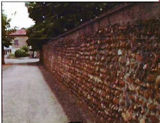
Mur en galets roulés.
