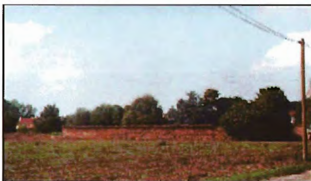
Ancien mur d'une bâtisse en ruine, en pisé.
