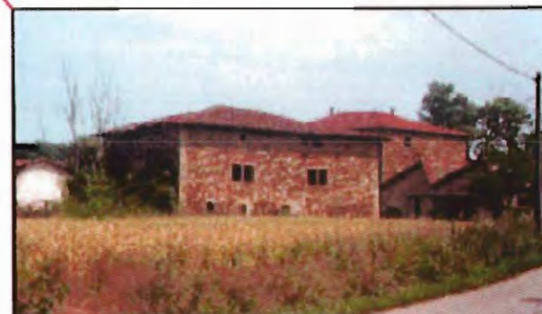
Bâtiments en galets roulés avec des contreforts en pierre de taille.
