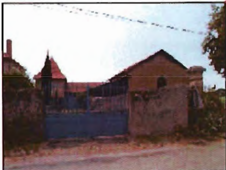
Bâtiment agricole en pisé.
