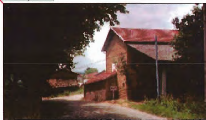
Bâtiment agricole en pisé, avec des soubassements en galets roulés.
