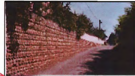
Mur en galets roulés.
