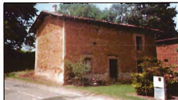
Bâtiment en pisé avec des contreforts en pierre de taille.
