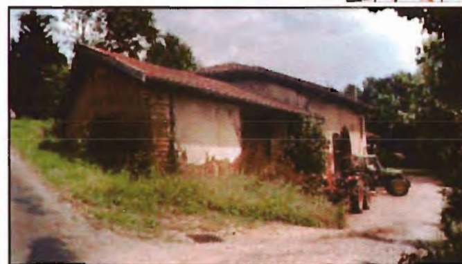
Bâtiment agricole en pisé.
