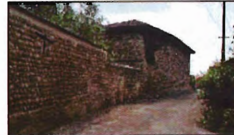
Mur de clôture en galets roulés de la propriété bourgeoise présente au hameau du Fer
