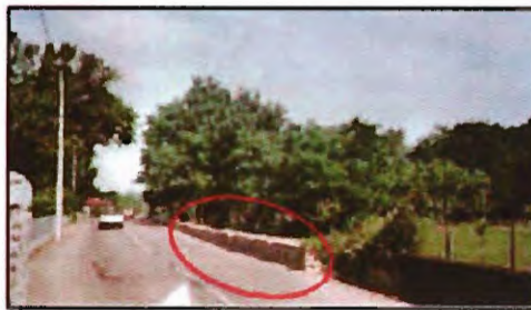
Muret en galets roulés.
