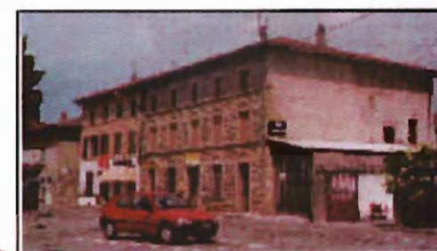
La poste en galets roulés, pisé, avec des contreforts en pierre de taille.
