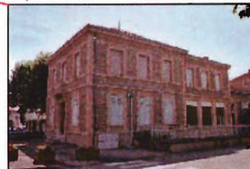
La poste en galets roulés, pisé, avec des contreforts en pierre de taille.
