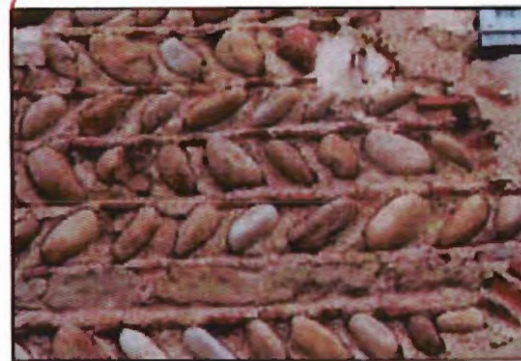
Avec des soubassements en galets roulés, puis le haut du bâtiment en pisé : c'est une technique antisismique.
