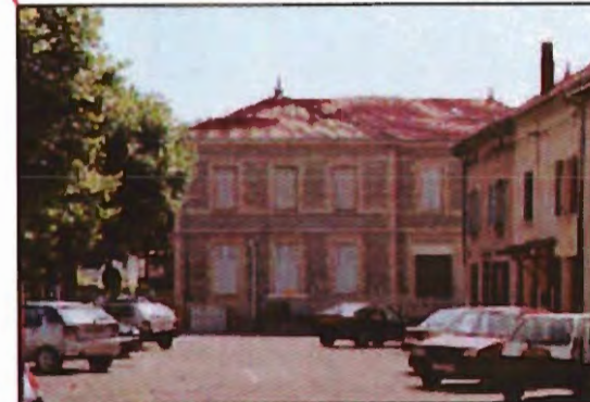
La mairie en galets roulés, avec des contreforts en pierre de taille.
