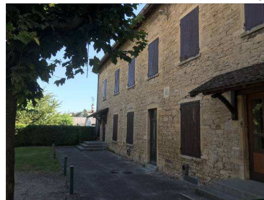
Bâtiment des associations (centre-bourg)
