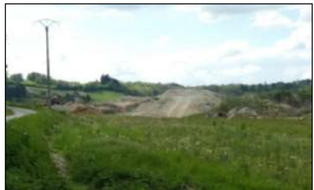
Dépôt divers à la Poudrière
