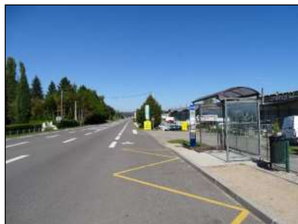
Arrêt de bus "Pont de l'Agné"
