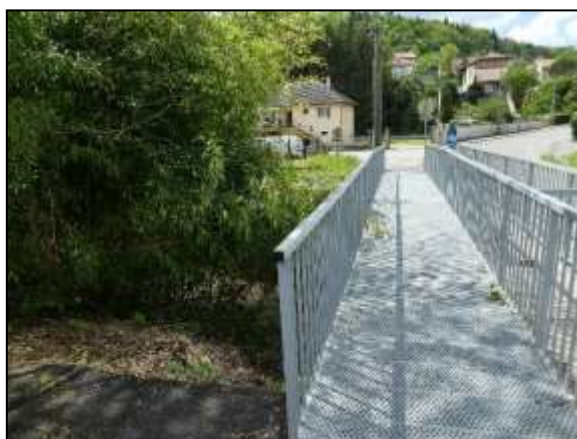
Aménagement d'une passerelle piétonne au-dessus de l'Agnay le long de la RD 59 (rue du Bas Vermelle)
