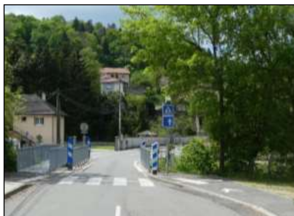
Panneau d'indication de priorité à la traversée du pont au-dessus de l'Agnay sur la RD 59a (rue du Bas Vermelle)
