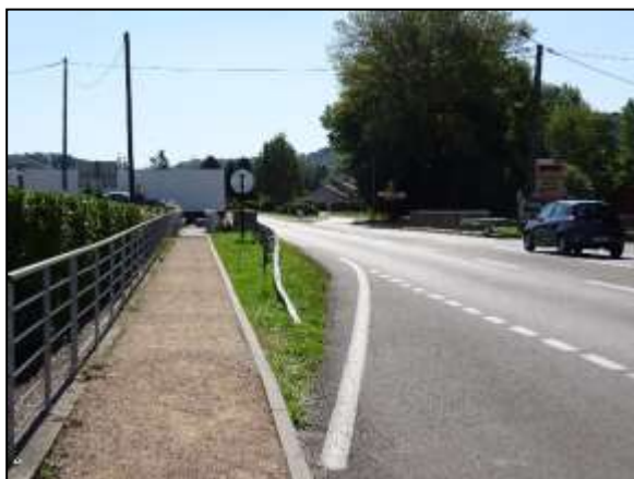
Aménagement d'un trottoir et d'une passerelle le long de la RD 1085
