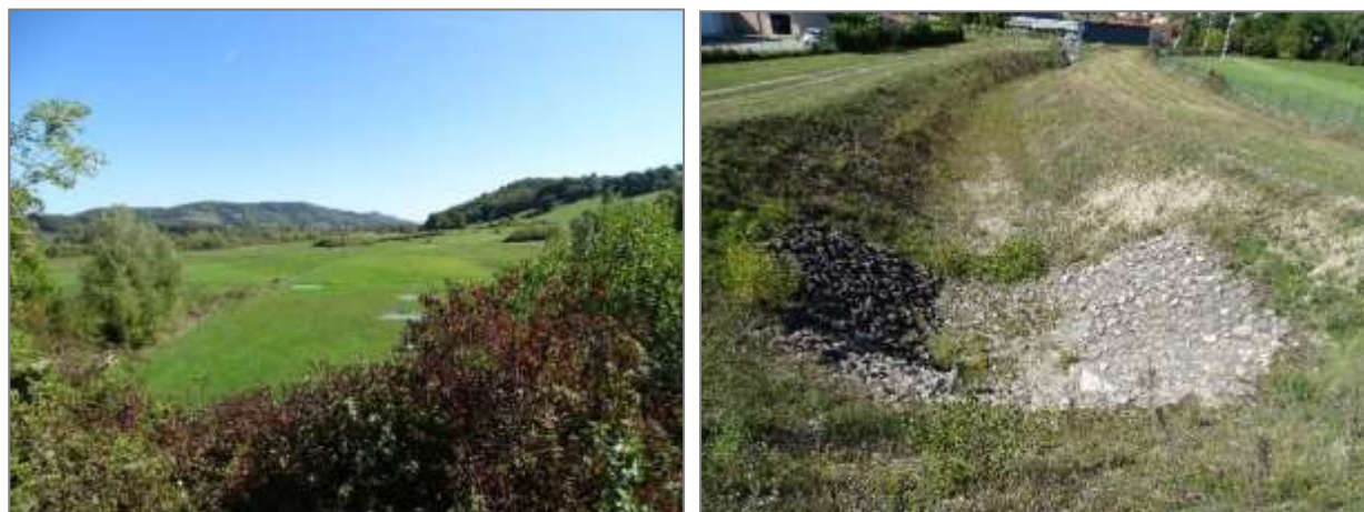
Equipements en lien avec le bassin écrêteur de la Plaine
