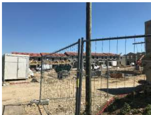
Chantier Villas Nova, sur la RD1085 (30 maisons groupées)
