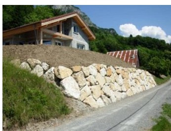
Exemple d' enrochements interdits
