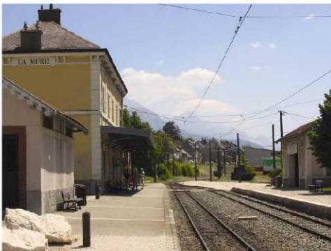
gare de La Mure
