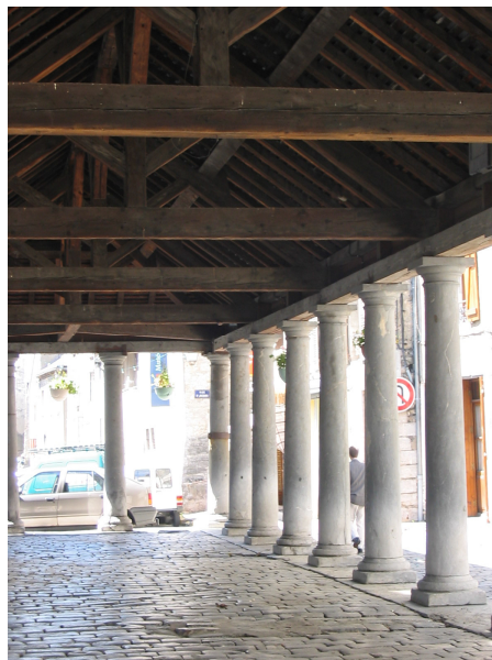
Intérieur des Halles
