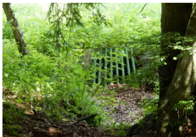
Figure III.7 : Photo de la grille d'entrée de la deuxième buse, vulnérable, directement à l'amont de la piste forestière.
