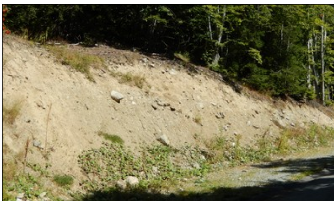
Figure III.9 : Affleurement de moraine dans un talus de la RD114E à l'amont de La Grande-Reine.
