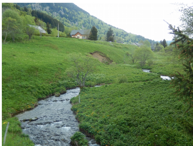
Figure III.5 : Photo du lit majeur encaissé du Guériment dans la zone aval. Les berges sont sensibles aux glissements superficiels.
