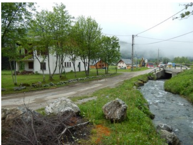
Figure III.4 : Photo du point de débordement du Guériment à l'amont du pont de la route de la Cascade (chemin des Jensannes). La première maison en rive gauche est particulièrement exposée.
