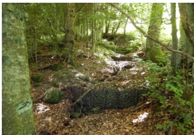
Figure III.6 : Photo du ruisseau du Grand-Serre dans sa partie de surface, boisée et équipée de seuils.
