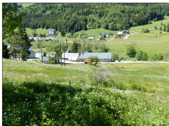
Figure III.8 : Zone de concentration des eaux de ruissellement à l'amont de la RD114, débouchant au droit du bâtiment central sur la photo.
