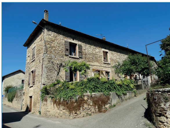
Habitation située à l'ouest de la zone 1AU
