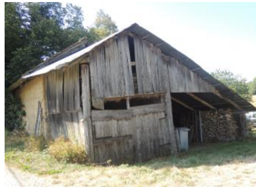
Grange servant d'abris bois sur le secteur de Haute Veronnière
