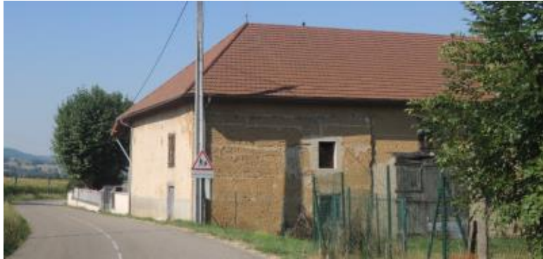
Grange située route des Grands Roseaux
