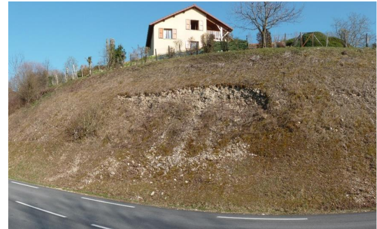
Glissement au dessus de la RD 90 entre la Véronnière et le Verney. Photo : Atelier BDa
