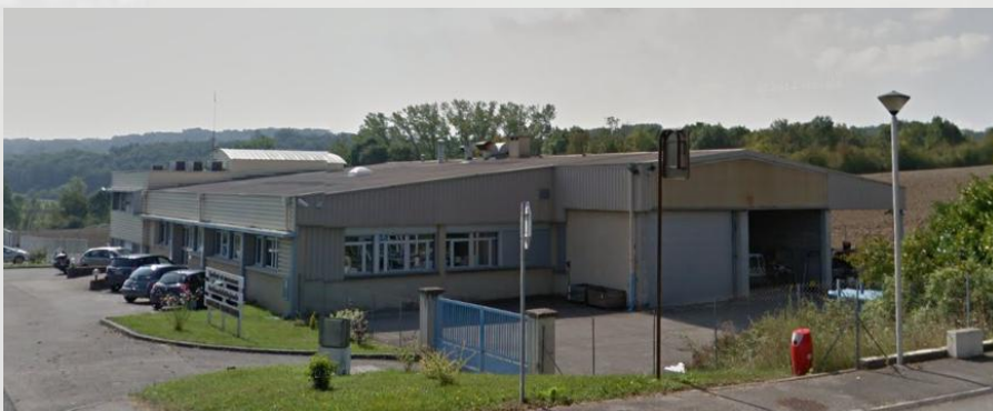
Bâtiment du syndicat des eaux
