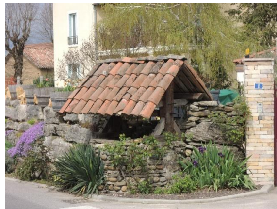
Ancien puit couvert restauré et mis en fleurs par le village
