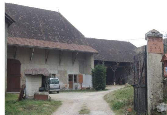
Toiture 2 pans à coyaux
