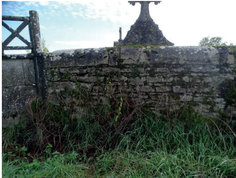
Muret en pierre – propice à la faune
