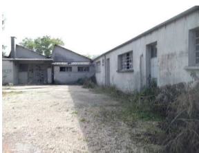
Photo 11 : Cour au nord-ouest des bâtiments C1 et B1
