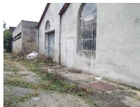
Photo 8 : Bâtiment A2 – Stockage de produits chimiques (non définis) – Bâtiment non visité
