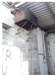
Photo 18 : Bâtiment C2 – Equipement
