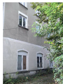
Photo 10 : Bâtiment A1 (anciens bureaux)
