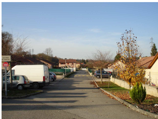
Espace viaire de lotissement vers Vercieu
