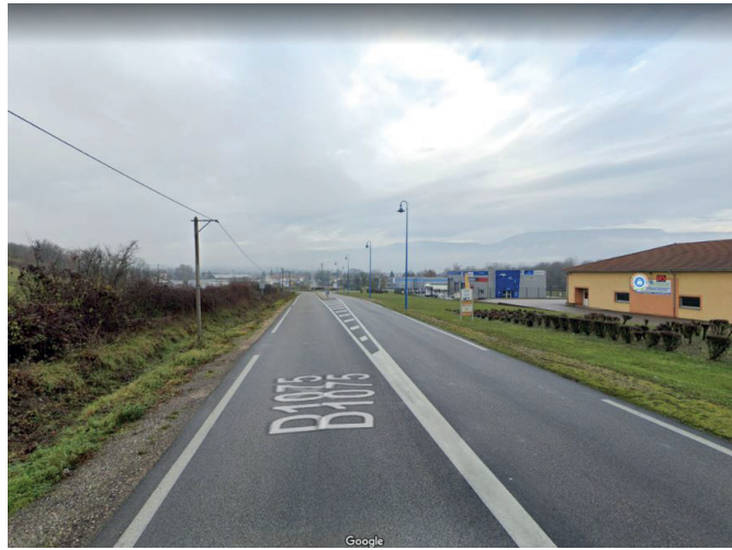
Entrée de ville par le sud avec vue sur les collines
