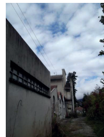
Photo 6 : Allée à l'est du site – Bâtiments B1 puis A2
