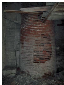
Photo 21 : Cheminée du bâtiment F
