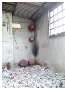
Photo 17 : Bâtiment C2 – Ancienne chaufferie
