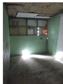
Photo 12 : Pièce du bâtiment E
