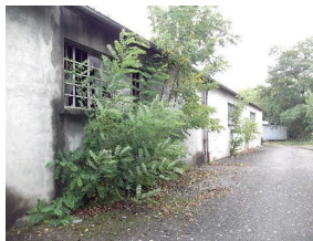
Photo 1 : Sud-ouest du site – Bâtiment D2 - Hors emprise Epora
