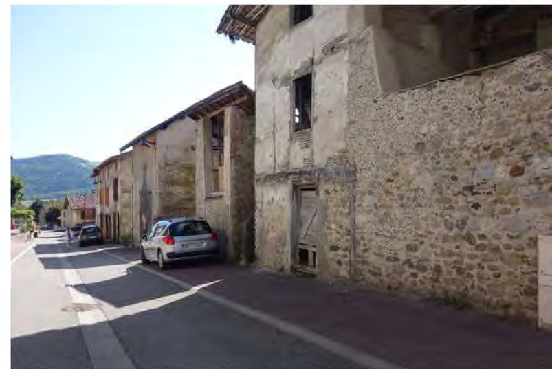
Un alignement du bâti sur rue à conserver. L'aspect rural des bâtiments est également à préserver.
