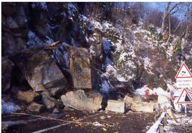
Figure 26 : Eboulement du 3 janvier 2004 (Source : Institut des risques majeurs)
