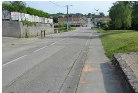
trottoirs sur la RD517a
