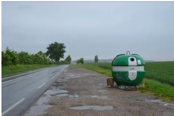
L'entrée ouest par la route de Crémieu est très routière, ses accotements sont mal entretenus
