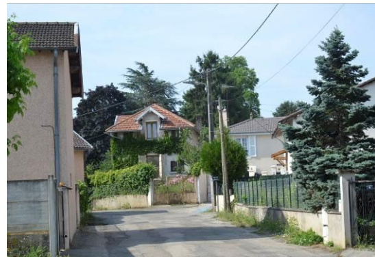
Les pavillons anciens dessinent la rue, l'équilibre est maintenu entre maisons, végétation et clôtures légères (murets bas)
