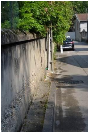
trottoir trop étroit dans une rue ancienne
