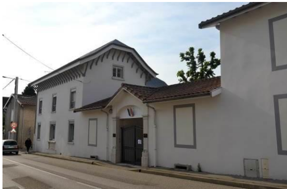
la mairie alignée sur la RD517a
