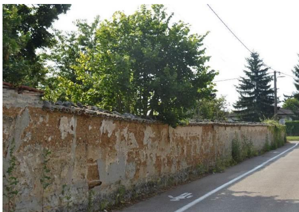
Mur en pisé
