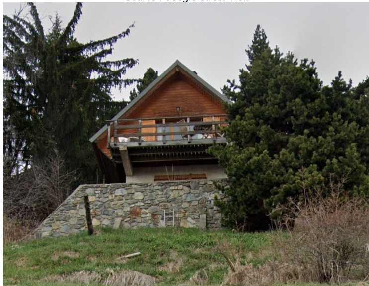
Exemple de chalets dans le lotissement du Grand Broue Source : Google Street View
