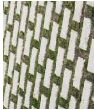
Pavage en béton avec ouvertures de drainage
