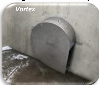
Système de cloison avec orifice
