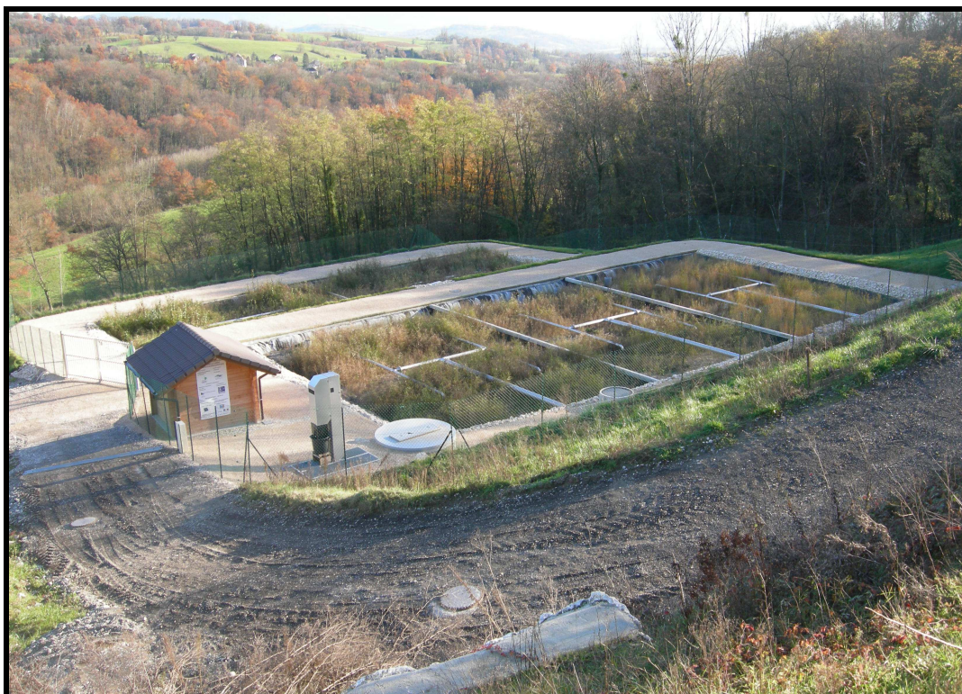
La station dans son ensemble, comprenant le dégrilleur et les 2 étages de lits à macrophytes
