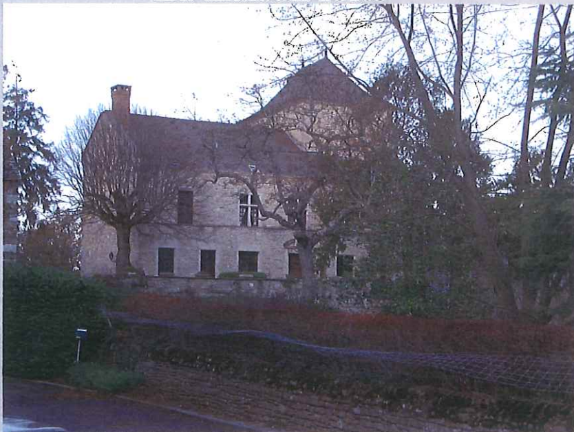
La maison forte
