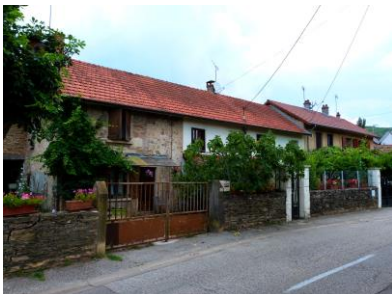
Front constitué de petits volumes bâtis accolés avec cour à l'avant
