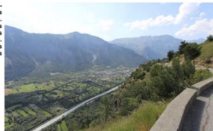
RD211a après l'Armentier - route en balcon et vue dégagée sur l'Oisans source : SCoT de l'Oisans
