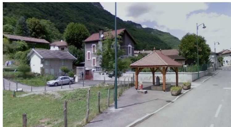
Bassin sur la bordure Nord-est
