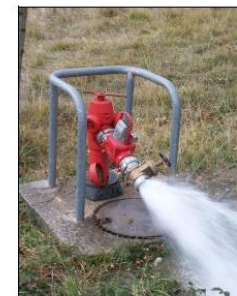
Mesure d'un poteau incendie
