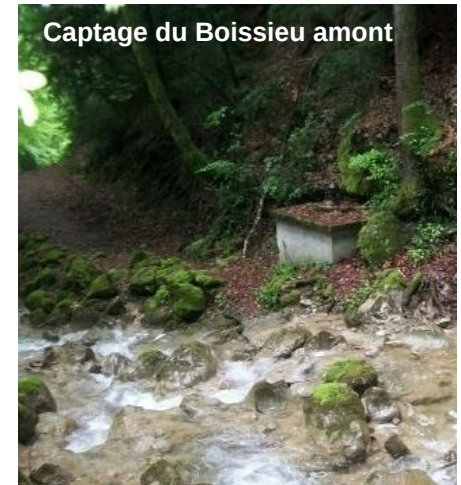
Captage du Boissieu amont
