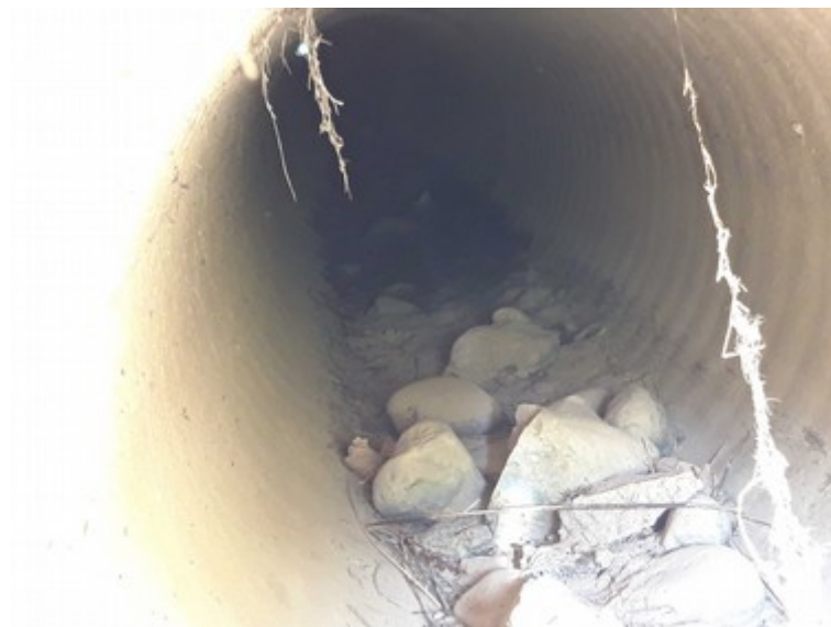
(d) Conduite de vidange – vue de l'intérieur en direction amont
