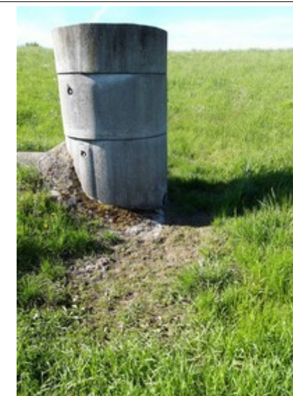
(g) Ouvrage de vidange et de sécurité
