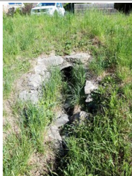
(a) Exutoire du réseau pluvial
