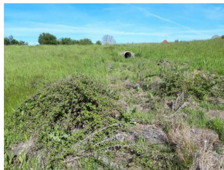
(e) Conduite pluviale et empierrement
