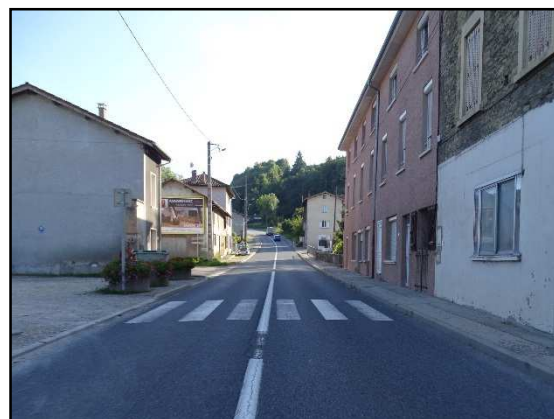
Passage piéton / trottoirs – La Combe-les Eparres
