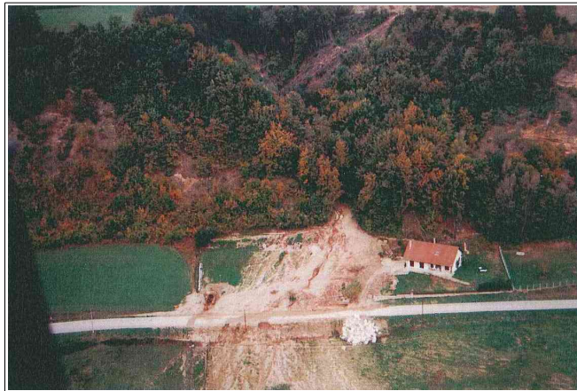
Divagation d'une combe dans la vallée de L'AGNY, à l'amont du village de la COMBE, le jardin de la maison et la RD56 ont été engravés.
