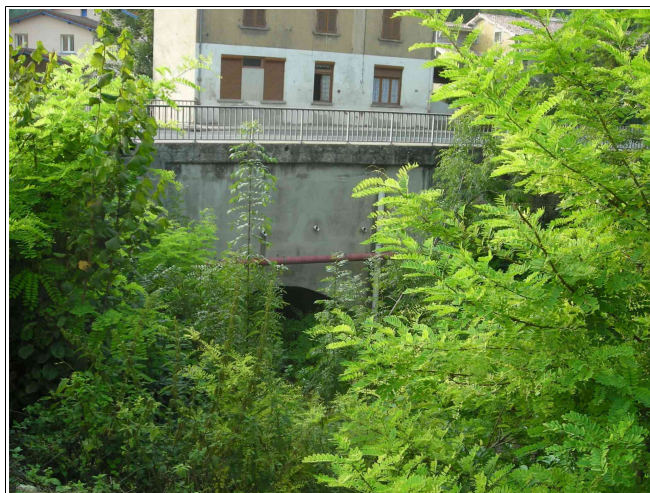
Vue du pont de la RD1085 depuis l'aval, on notera sa section plutôt étroite et l'encombrement par la végétation.
