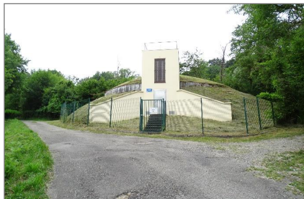
Réservoir des Blâches
