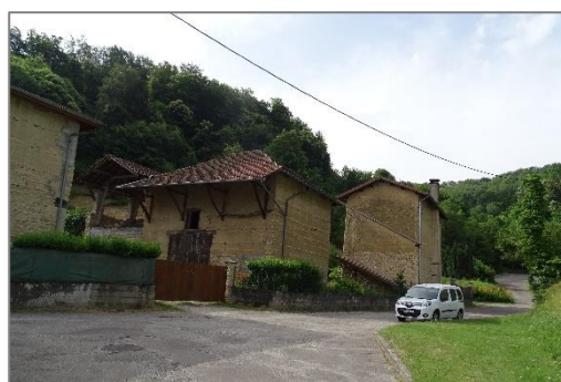
Bâti ancien dans le bourg
