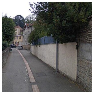
Exemple de mur structurant
