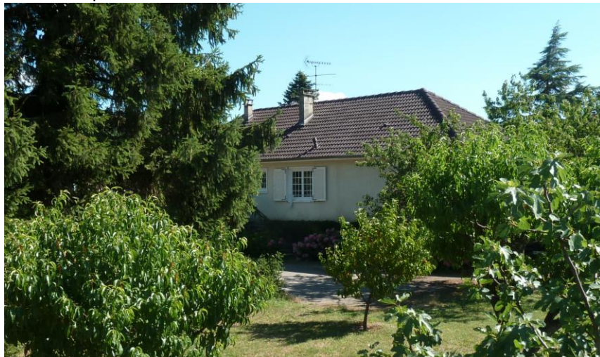
Figure 9. Bâtiment existant pouvant être maintenu
