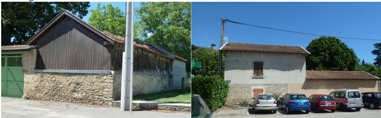
Figure 3. Bâtiments à démolir (à gauche bâtiment repéré au nord de l'AVAP, à droite bâtiment au sud)
