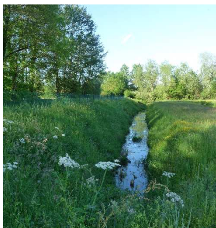
Fossé à proximité du lagunage
