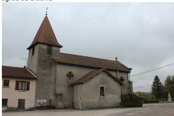
Eglise de Crachier
