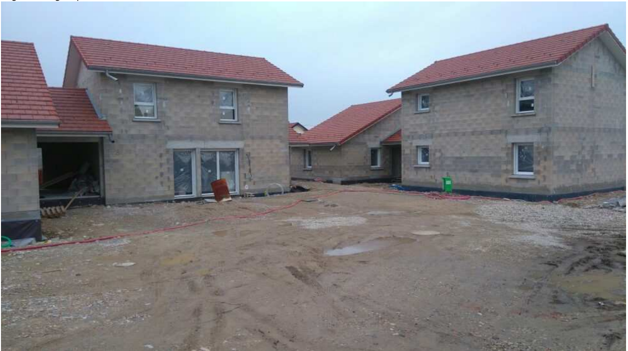
Logements groupés en cours de construction
