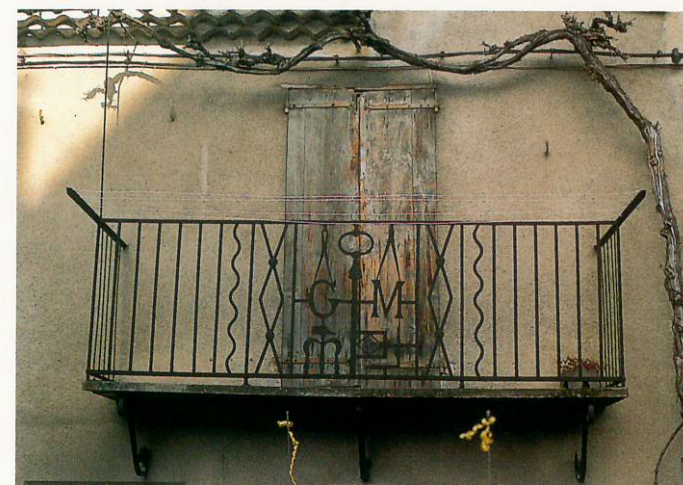
Exemple de ferronnerie sur fond de crépi traditionnel
