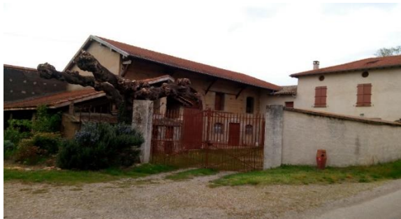
Ancien bâtiment agricole route du Sablon
