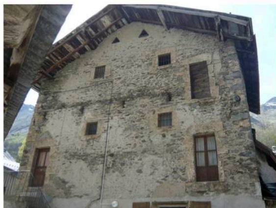
Une façade secondaire mais composée (organisation des ouvertures entre elles) avec ses portes, ses petites ouvertures et en haut les trous d'aération du fenil. Chaque porte devait comporter un escalier.
