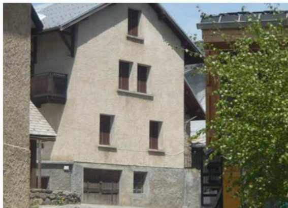
Ce bâtiment, fortement transformé, a perdu toutes ses qualités d'origine : enduit à la chaux, ouvertures d'origine, perception des usages d'origine.
