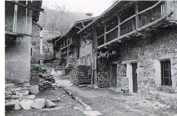
Photo du même bâtiment en 2000 et 2012 à Clavans le Haut. Les galeries de séchage sont exposées au sud. La rampe d'accès à la grange est cachée en 2012 par un appentis. Les réserves de bois sont intégrées au bâtiment. Le caniveau traditionnel en pierre a disparu.
