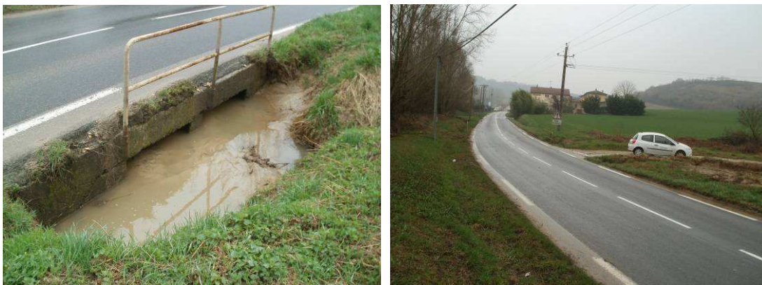
Colmatage du passage du pluvial sous la RD 123
