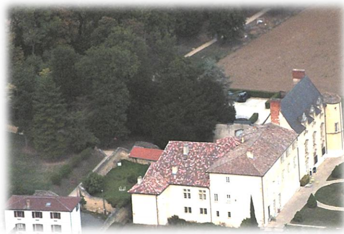
Allée des Tilleuls Cadastre : AH 346-347-400-401 Proche du chemin de Saint-Laurent
