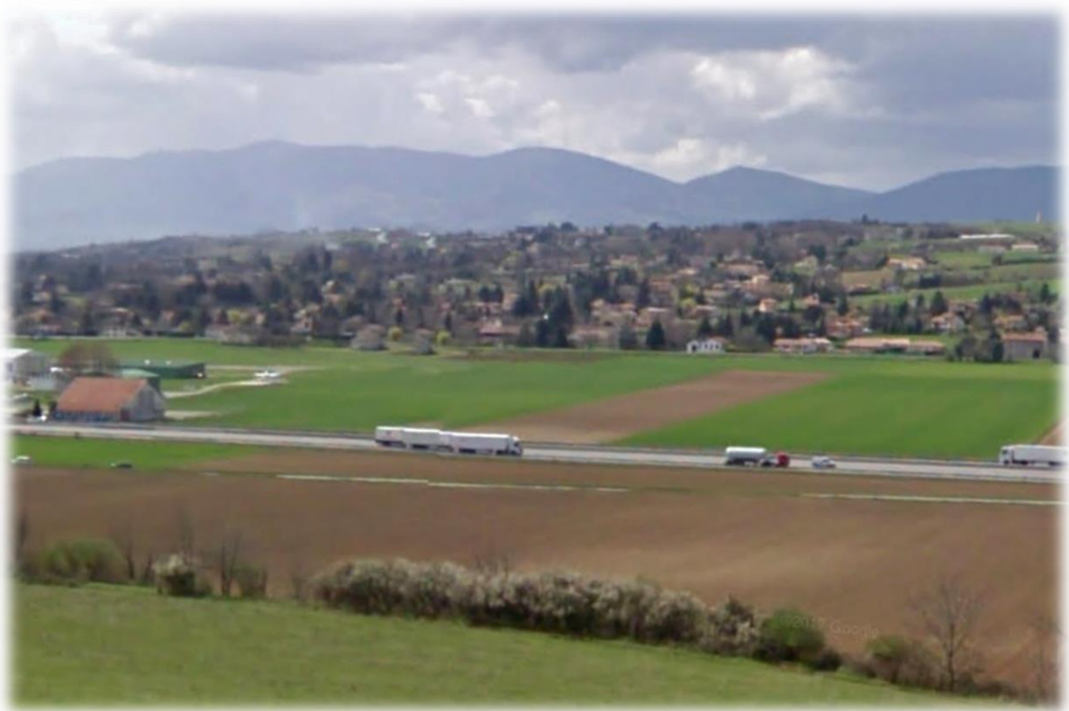
Vue de Chonas l'Amballan depuis le village de Reventin (au premier plan : l'autoroute A7)
