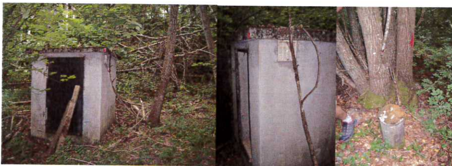
Figure 9 : Captage de Bergogne et Josserands et plot béton matérialisant le « massif drainant »
