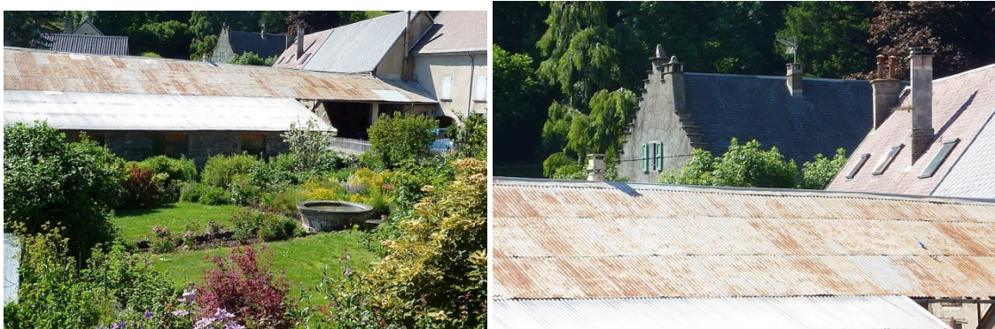
Mosaïque de matériaux de toitures (tôle, tuile, ardoise) - photos N. Bernard 2012
