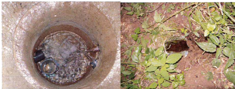
Figure 14 : photo de gauche : Intérieur du captage : arrivées d'eau des drains A et B, adduction et trop-plein -photo de droite : extrémité de la conduite de trop-plein
