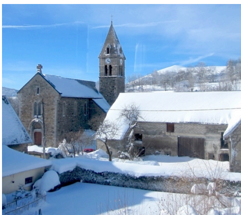
Vues sur l'église : pignon côté est, façade côté sud
