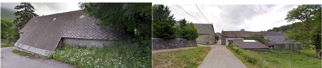
Grande pente nord d'un toit rue de l'Ederan, entrée nord du bourg par la Coirelle Photos Google Earth 2014
