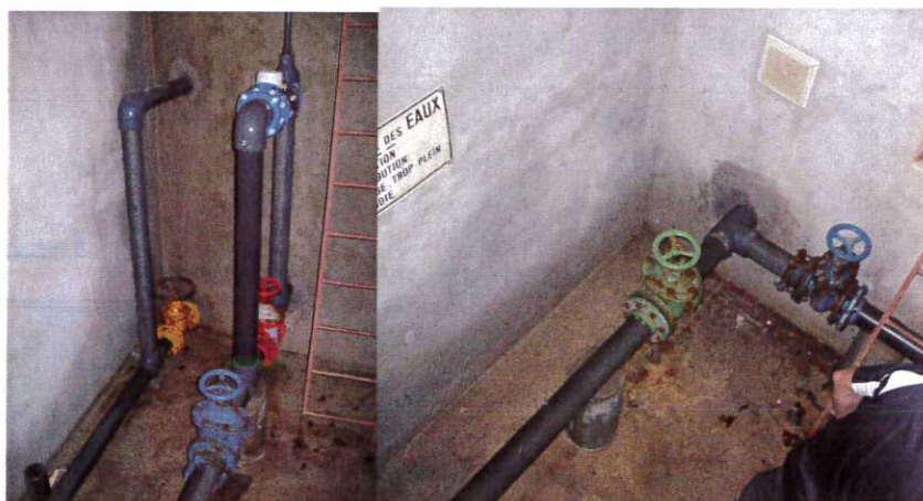
Figure 24 : Vue intérieure du réservoir de La Coirelle
