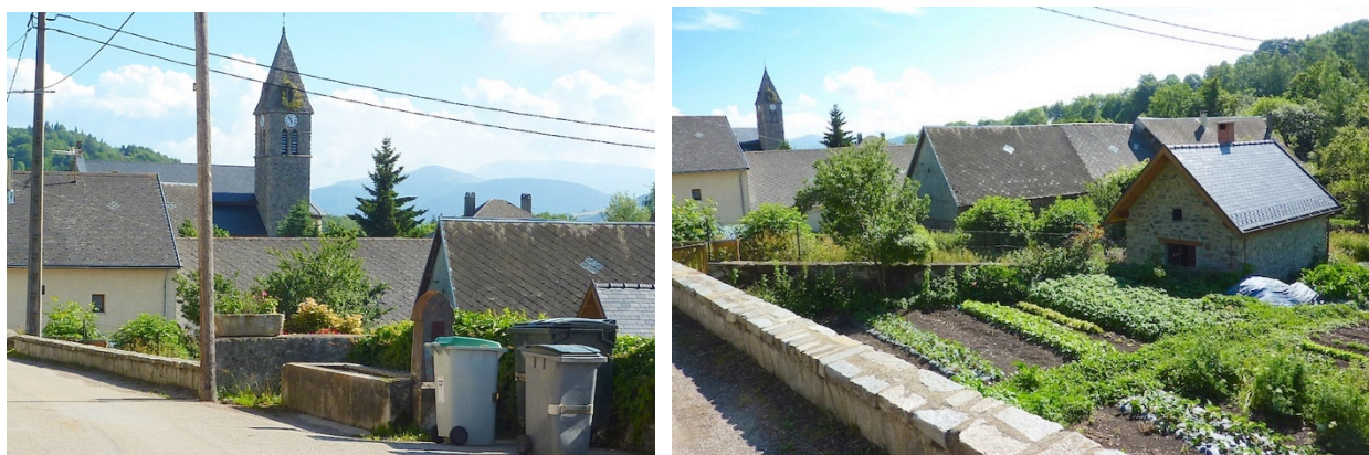
Prégnance des fermes de pierre et des toits d'ardoise, égayées par les jardins ouverts Photos N. Bernard 2012
