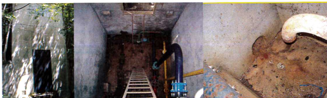
Figure 23 : Vue du réservoir de Bergogne-et-Josserands (extérieur, intérieur)
