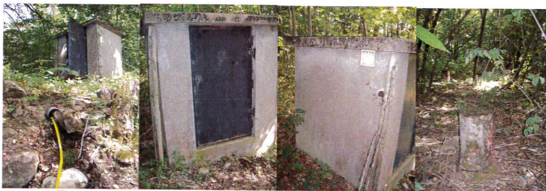
Figure 6 : Captage de Claudi et plots béton matérialisant le « massif drainant »
