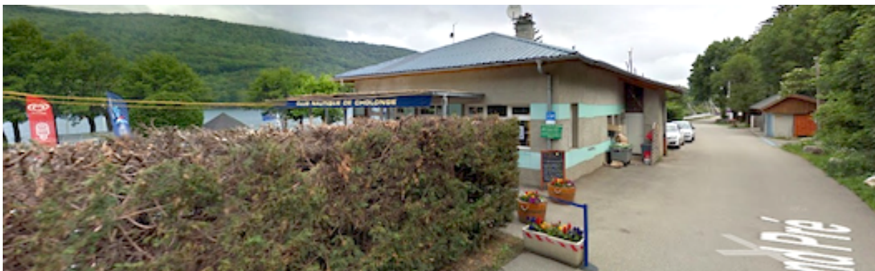
Bâtiment d'accueil et toilettes de la base nautique, en bordure du chemin des Buis (ou chemin du Grand Pré) - photo Google Earth 2014
