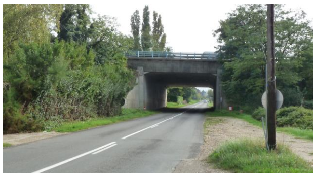
Entrée Ouest de Cheyssieu, RD 37 passant sous l'A 7
