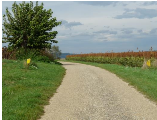
Canalisation de gaz Grand Baleya
