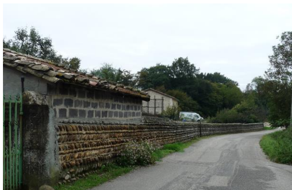
Murs traditionnels en galets Route de Cuillery
