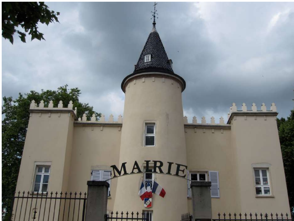
La mairie, un exemple de reconversion du patrimoine architectural
