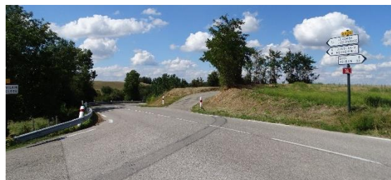
Intersection dangereuse de la rue du centre avec la RD 520
