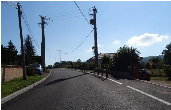
Aménagement piétonnier le long du chemin Darefin
