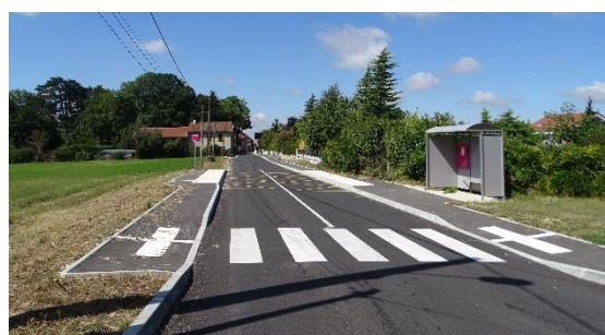
Traversée piétonne sécurisée sur le chemin Darefin
