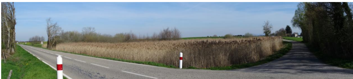
Zone humide à l'intersection de la RD 520 et du chemin des Routes (lieudit La Carte)
