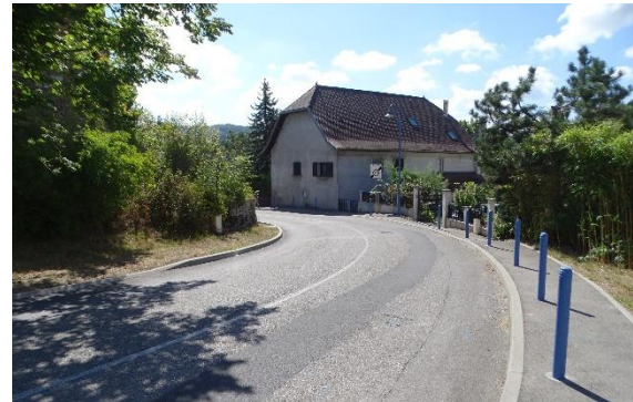
Trottoir piétonnier sur la RD 56a à Franchisson
