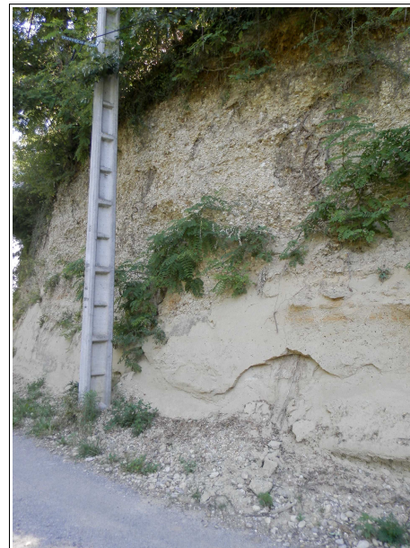
Figure n°22: Chutes de pierres au niveau du « Chemin des Tourtes »
