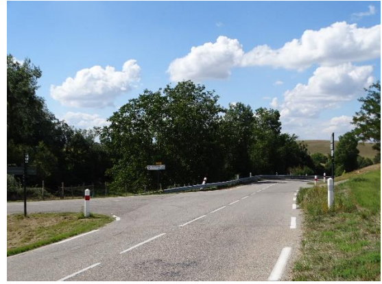
Route de Biol (RD 520) au niveau de l'intersection avec la rue du centre (RD 56a)
