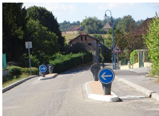
Aménagement cyclable le long d'une chicane sur la rue du centre
