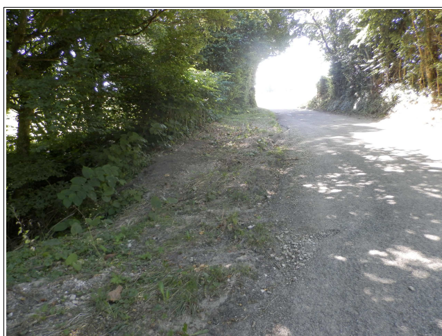
Figure n°19: Traces de ruissellements sur le « chemin de la Buissonnière »
