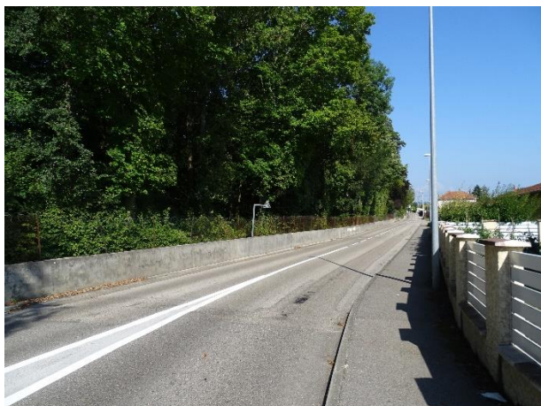
Lisière Sud du parc, entre le rond-point et la rue de la République, mur de clôture et soutènement.
