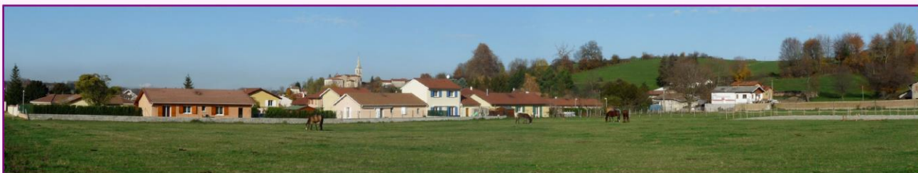
Ensemble bâti perceptibles depuis la RD 53
