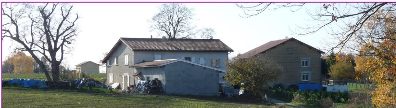
Bâti en haut du chemin du Mariage
