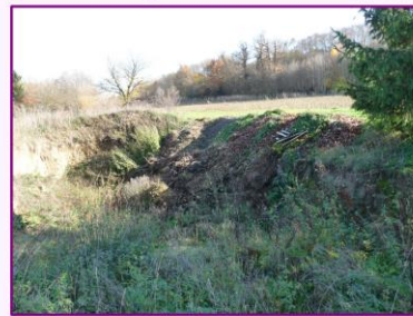
Remblaiement à côté de l'Amballon
