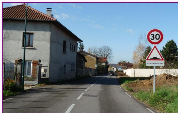
Traversée urbaine de l'avenue du Dauphiné (RD 53)
