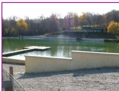
Étang au droit du chemin des Grenouilles et du chemin de Jacqueron
