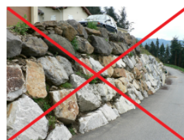
Exemple d'enrochements de type cyclopéen
