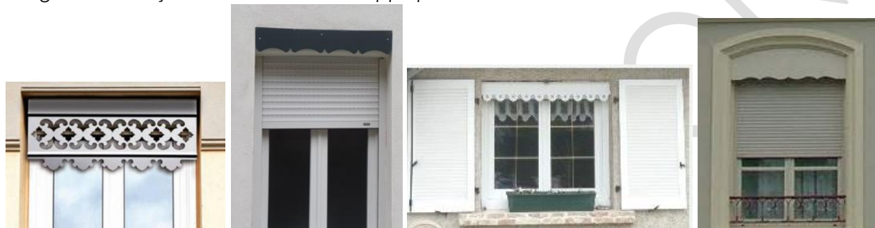
Exemple de dispositifs d'habillage des coffrets
