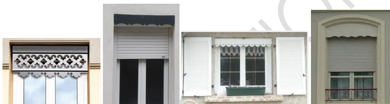
Exemple de dispositifs d'habillage des coffrets
