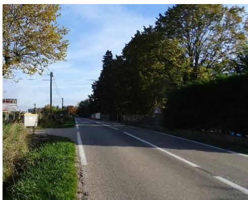
RD 75 au droit du centre équestre
