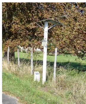
Conduite d'hydrocarbures aux Sétives
