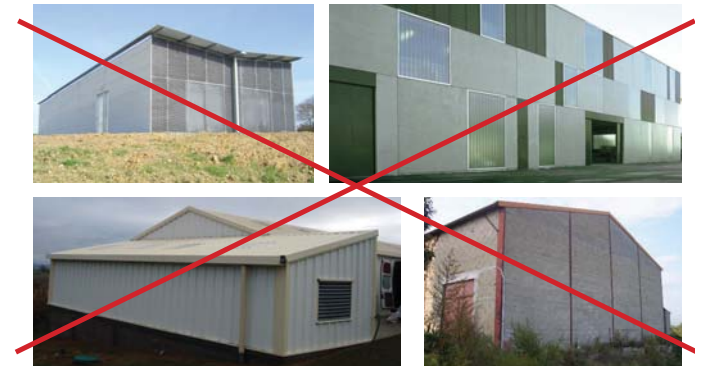
CONTRE-EXEMPLE : matériaux réfléchissants, matériaux de couleurs blanches ou trop clairs, parpaings laissés apparents...
