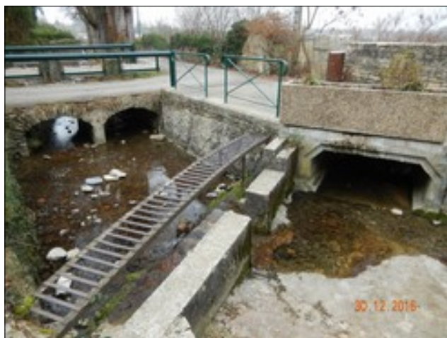
Photo 5 : Aménagement du ruisseau des Grottes à l'aval du lavoir. A droite de la photo le dalot initiant le canal de dérivation.
