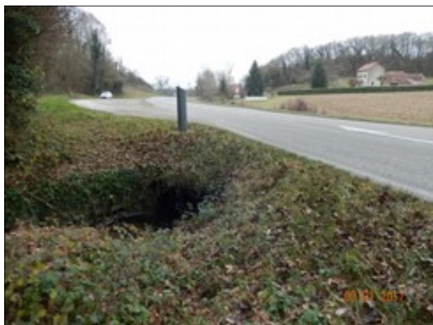
Photo 11 : Passage du ruisseau d'Amblérieu sous la RD52c.
