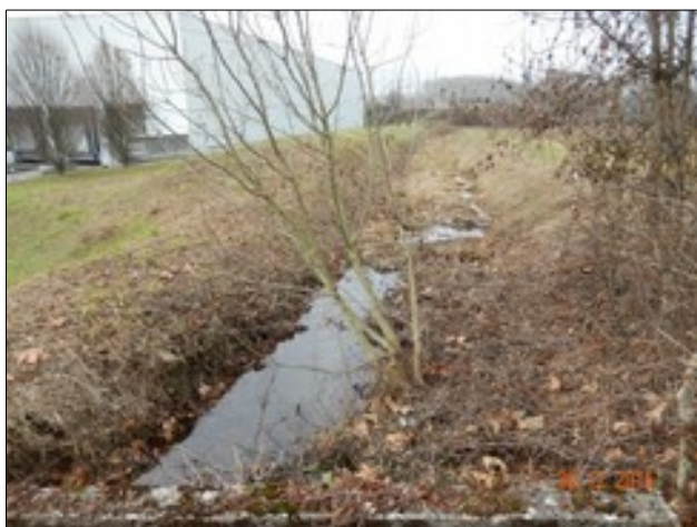
Photo 10 : Levée de terre en rive gauche du ruisseau des Grottes à l'aval de la route de Port-Michaud.
