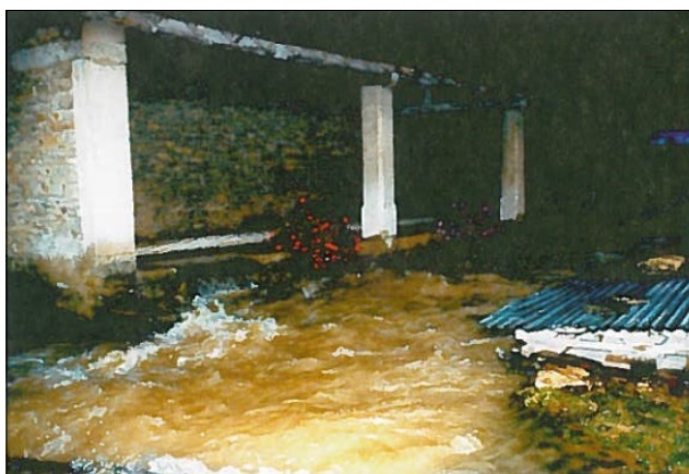
Photo 1 : Débordement du ruisseau des Grottes au niveau du lavoir le 12 octobre 1988 (source: Le Balmolan - 2000).
