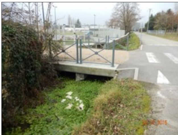
Photo 8 : Ponceau du ruisseau des Grottes à l'aval de la RD65i.
