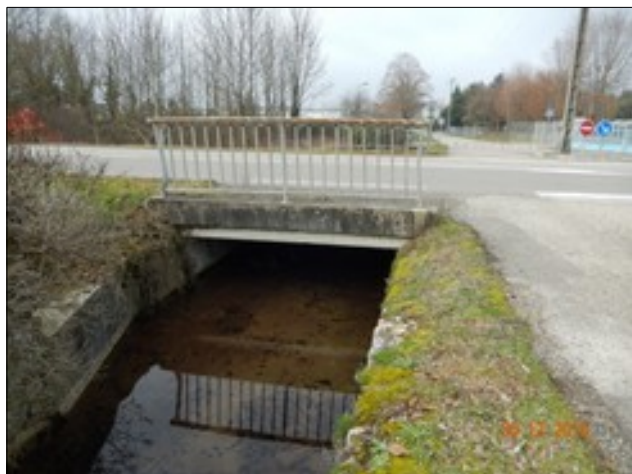
Photo 7 : Pont du ruisseau des Grottes au niveau de la RD65i.
