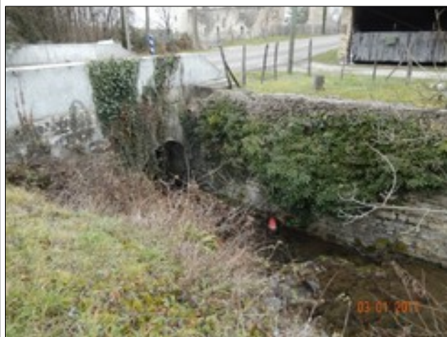
Photo 12 : Passage du ruisseau d'Amblérieu sous la RD65.
