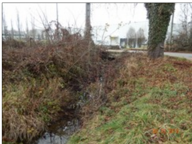
Photo 9 : Pont du ruisseau des Grottes sous la route de Port-Michaud.
