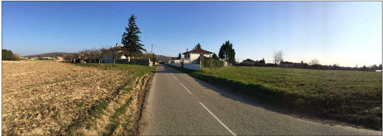
Entrée Nord-Ouest d'Assieu menant également au quartier de Bruyères
